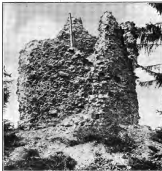
Nordansicht der Burgruine.
